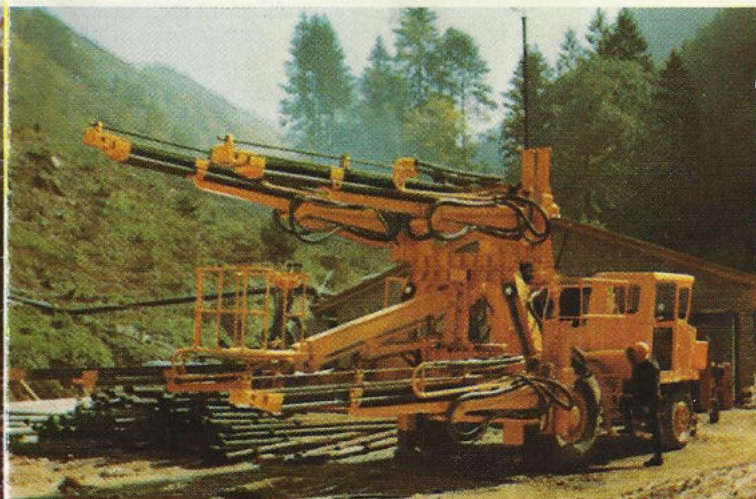
▲ Bohrwagen mit 4 Bohrhämmern für den Stollenvortrieb ◀ Vorbau der Grabenwaldbrücke mit Südportal des Grabenwaldtunnels
