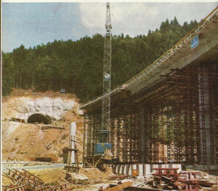
▲ Baustelle Hornbergbecken im Herbst 1971. Auf der Beckensohle der Voreinschnitt für den Druckschacht.
