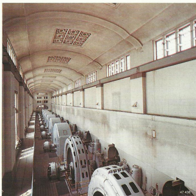
6 Generatorhalle im heutigen Kraftwerk vor dem Ausbau.
