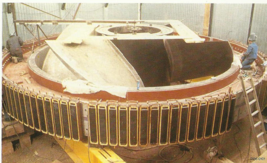
12 Einbau der Pole auf einem STRAFLO-Rotorkran (Annapolis Royal, Kanada).
