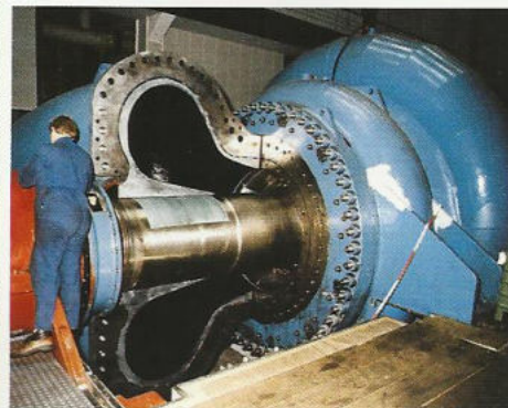
Montage einer Pumpe in der Maschinenkaverne
