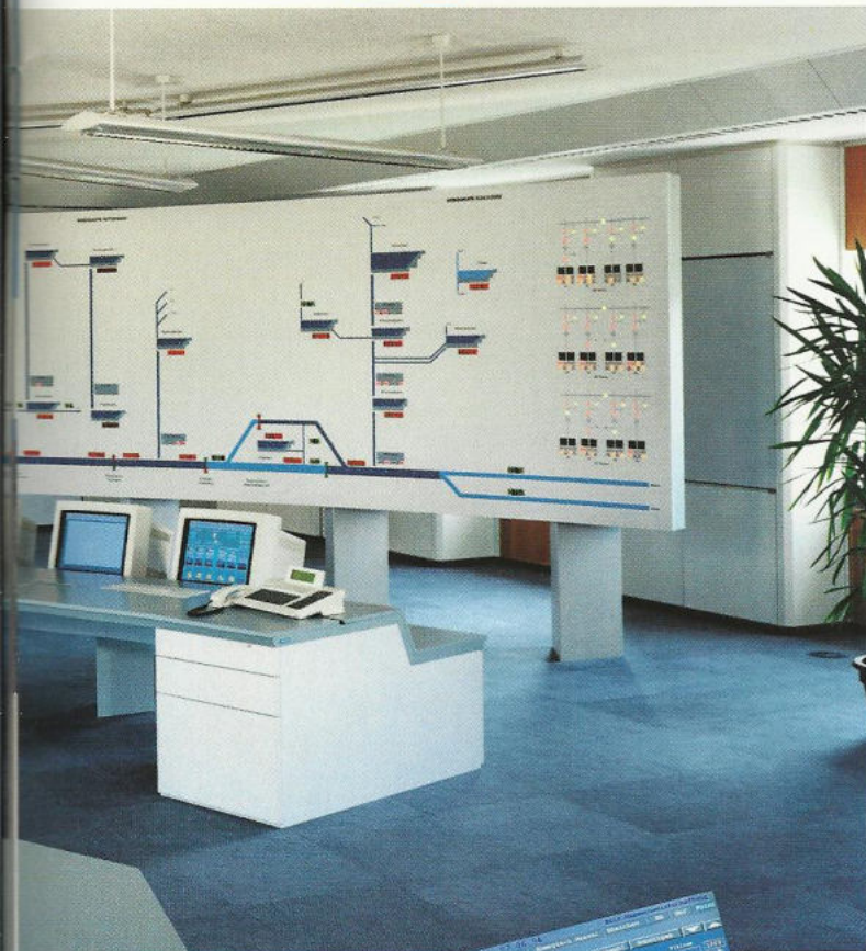
Warte für den zentralen Kraftwerkseinsatz und Betriebsführung der Schaltanlage Kühmoos
