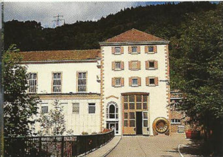
Eingang Kraftwerk Witznau
