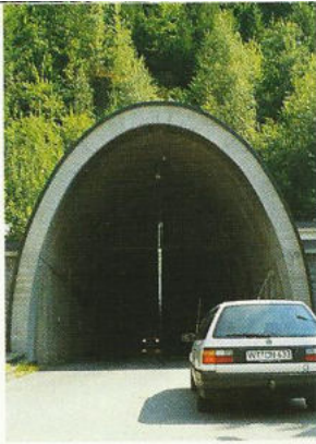
Zufahrtsstollen zur Maschinen- kaverne
