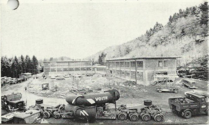
▼ Betriebsgebäude mit Transport der Pumpenspirale
